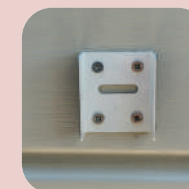
Fixer la descente de gouttière à l'aide des 2 vis inox déjà en place sur les pattes de fixations
