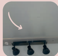
Ventilation sous le cache faitière
