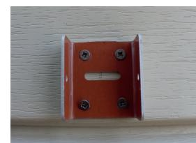
Fixer la descente de gouttière à l'aide des 2 vis inox déjà en place sur les pattes de fixations
