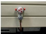
Fixer le limiteur-pré-détendeur-inverseur avec 2 vis.
