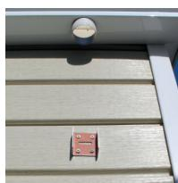
Mettre en place la descente de gouttière dans son logement.
