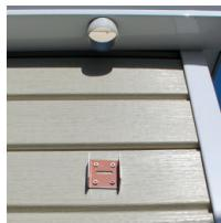
Colocar la bajante del canalón en el acoplamiento correspondiente.
