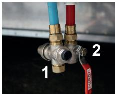
1- Conexiones de desagüe para vaciar el circuito de agua fría de consumo humano.
