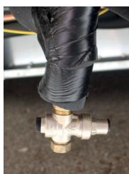
Se raccorder sur le raccord mâle 15/21 placé sous le plancher de la résidence mobile.
