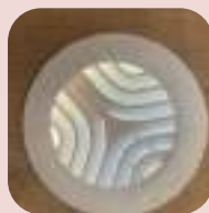
Salida de ventilación baja
