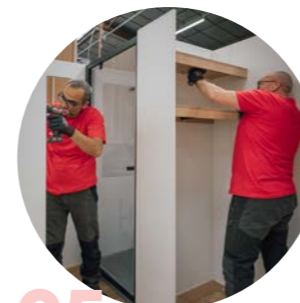
05 Mise en place des équipements intérieurs
