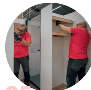
05 Instalación de los equipamientos interiores
