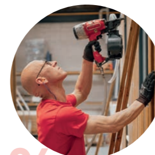
06 Aislamiento y revestimiento exterior
